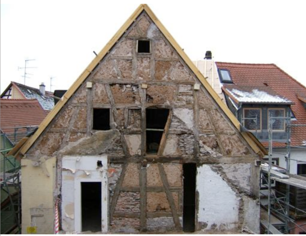
Giebel Vorderhaus von Ost: Urzustand mit neuer Dachdämmung
