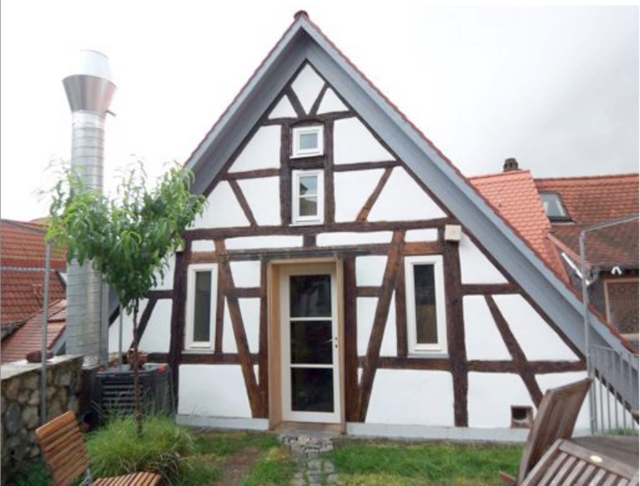
Giebel Vorderhaus von Ost: Fertig mit Lehmputz und gestrichen
