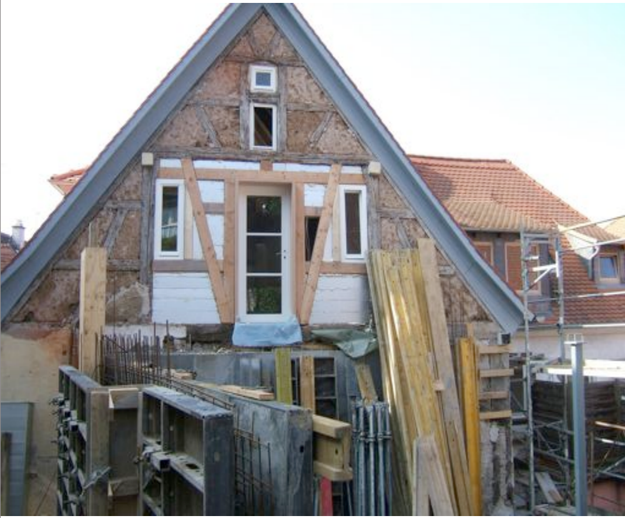
Giebel Vorderhaus von Ost: Mit Dämmelementen gefüllte Gefache
