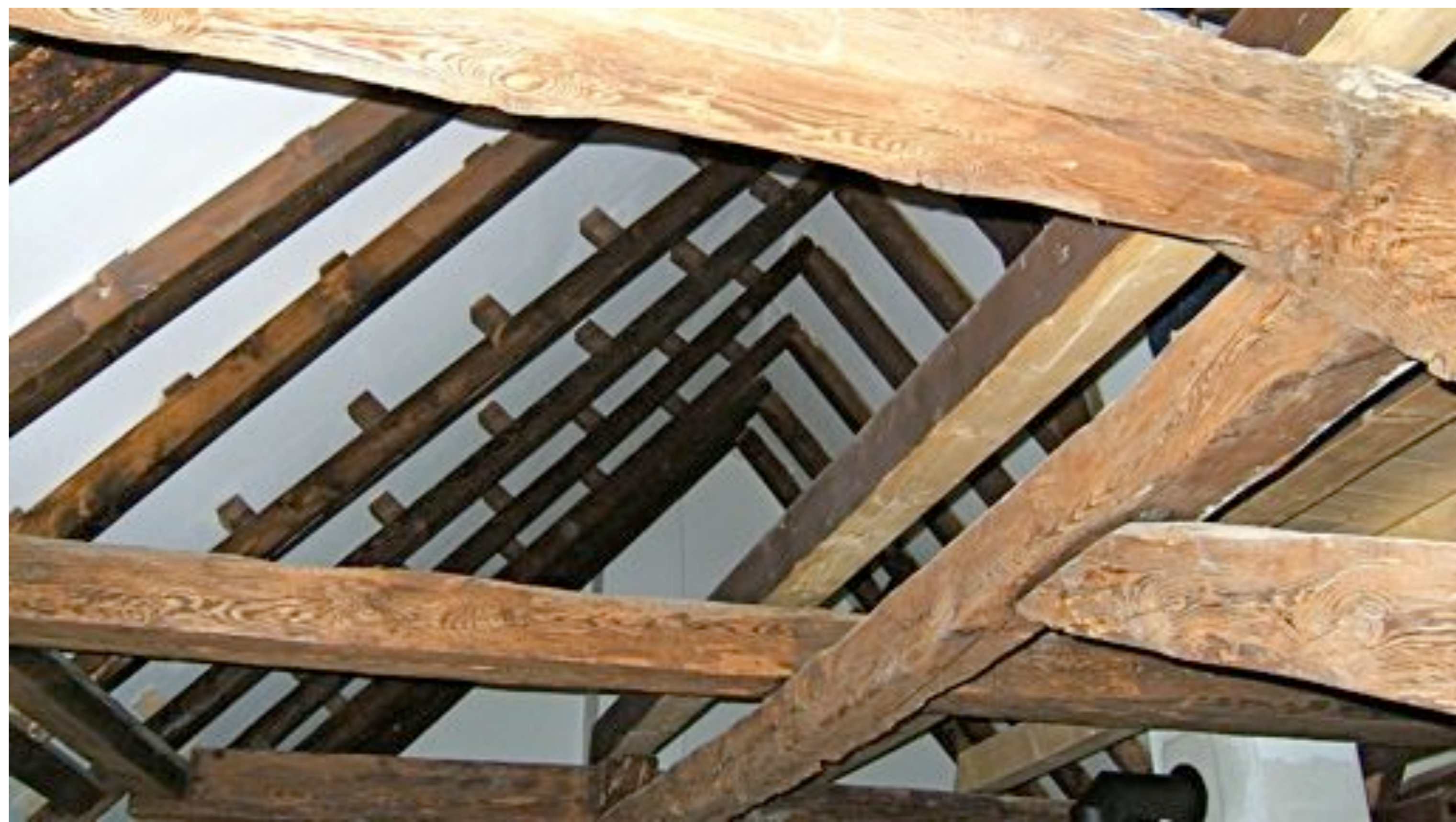
Blick in das Dachtragwerk mit der durch Klötzchen abgesetzten Dämmschicht
