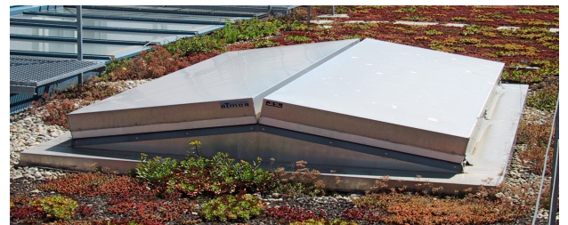
Hochgedämmte RWR-Klappen mit doppelten Luftdichtungen Detail Pfosten-Riegel Fassade
