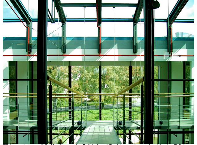
Blick vom Labor auf die Verglasung der Cafeteria mit Dachtragwerk und abgehängten Brücken
