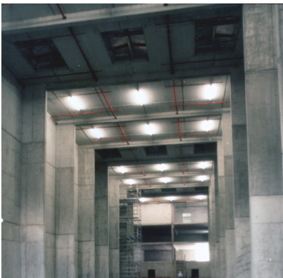
Schotten im Hochregallager Verbindung Produktion/Lager
