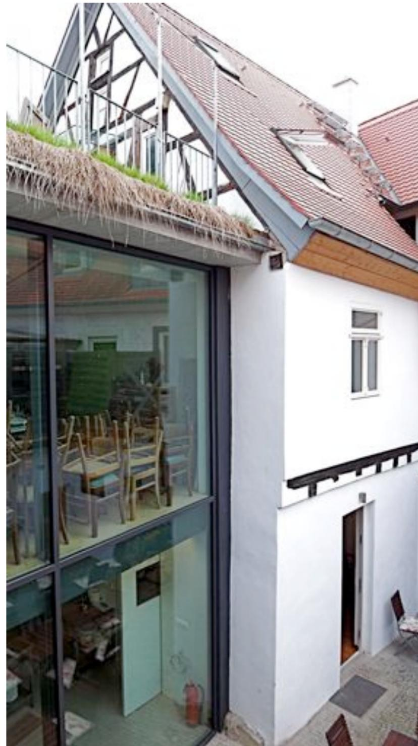
Blick in den Hof auf den Übergang Neubau zu Altbau mit fertigem Dämmputz.
